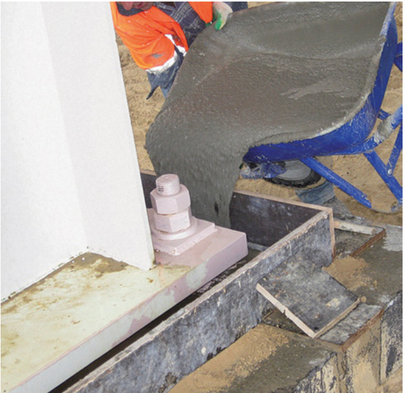
Решение 5. Подливка фундаментных болтов в анкерных колодцах
