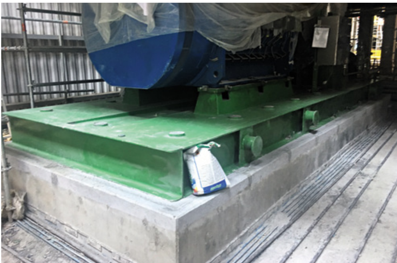
Подливка фундамента турбин, комплексов оборудования и металлоконструкций материалами MAPEI
