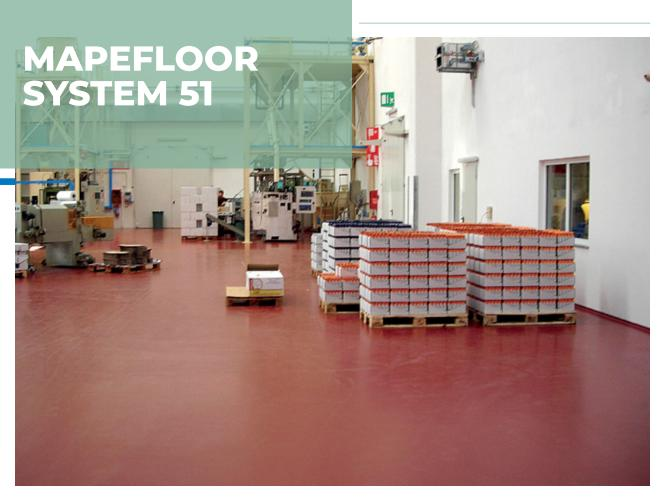
Противоскользящее полуматовое паропроницаемое бесшовное эпоксидное напольное покрытие. Толщина покрытия 2,5-3,0 мм.
