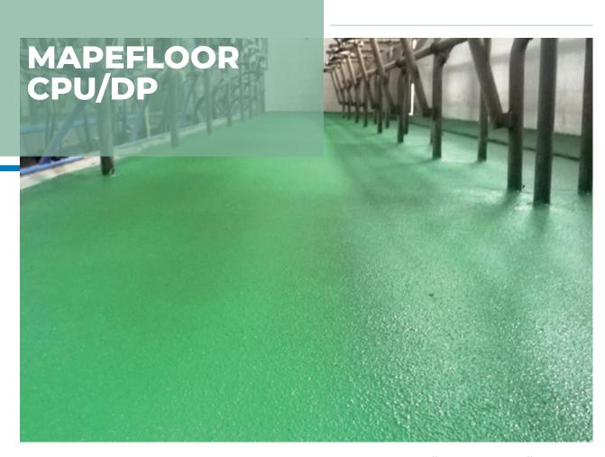
Полиуретан-цементное противоскользящее покрытие с высокой механической прочностью и высокой химической стойкостью для промышленных полов. Толщина 3-4 мм. Соответствует стандартам пищевой промышленности.
