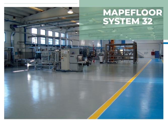
Противоскользящее бесшовное эпоксидное напольное покрытие толщина 3,0-3,5 мм.
