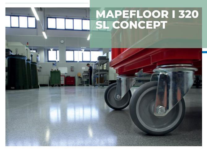
Гладкое глянцевое бесшовное эпоксидное напольное покрытие с зернистым рисунком. Толщина ~ 2 мм.
