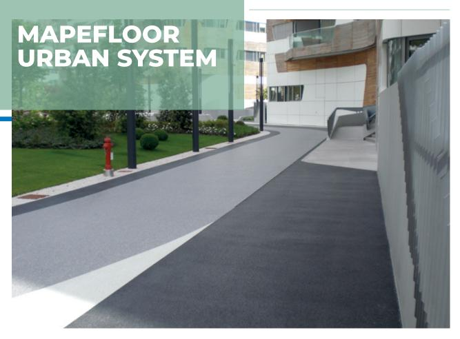
Дренирующее декоративное полиуретановое алифатическое покрытие из смеси вяжущего и натуральных заполнителей (2-4 мм или 4-8 мм) для наружных поверхностей.
