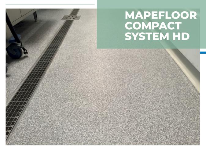
Высоконаполненное покрытие с закрытыми порами с высокими эстетическими свойствами для промышленных и коммерческих полов. Толщина 5,0-8,0 мм.
