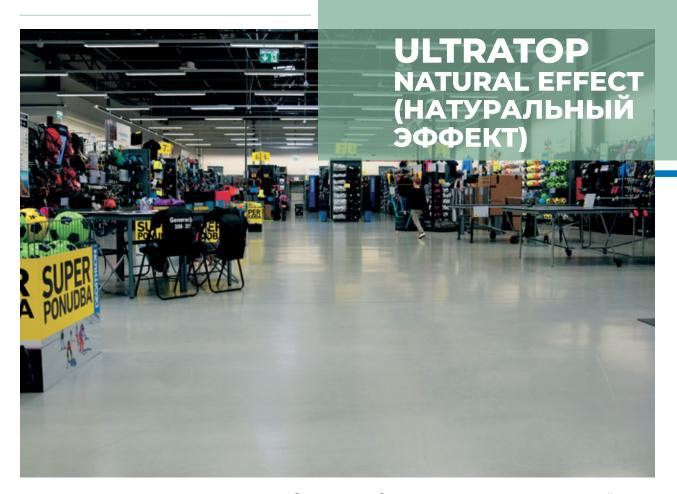
Гладкое цементное покрытие с очень быстрым набором прочности для износостойких полов. Толщина 5-40 мм.
