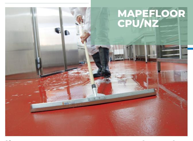
Облегченное в укладке полиуретан-цементное покрытие с высокой механической прочностью и стойкостью к химическим веществам и тепловым ударам для противоскользящих промышленных полов. Толщина 4-6 мм.
