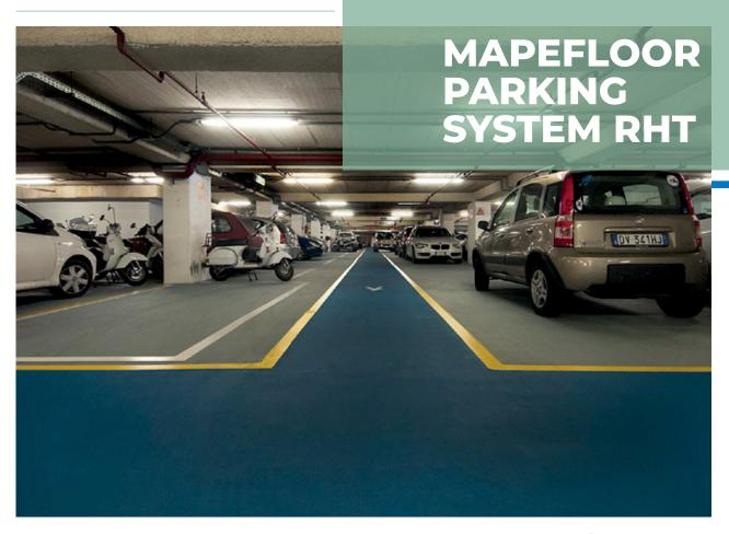
Бесшовное эпоксидное покрытие для поверхностей с пешеходным и интенсивным автомобильным трафиком. Покрытие соответствует требованиям Rili DafStb (Методические рекомендации Немецкого комитета по железобетону), OS8. Может применяться для защиты бетонных поверхностей согласно EN 1504-2. Толщина 3-3,5 мм.
