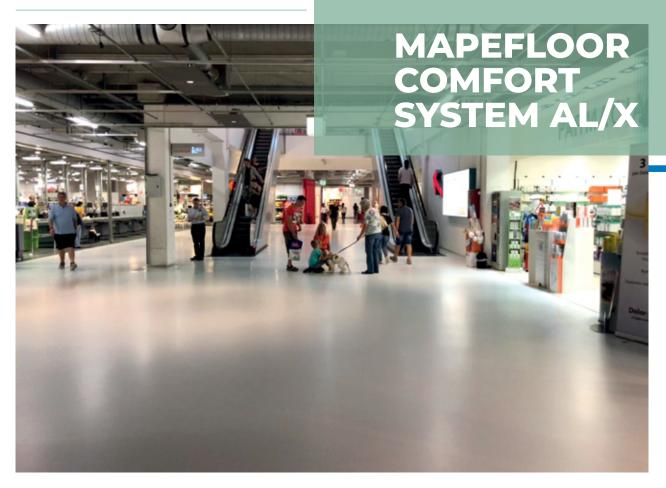
Полиуретановое алифатическое эластичное гибкое гладкое покрытие для полов в зданиях гражданского назначения. Толщина 6 мм.
