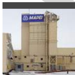
Завод пос. Кикерино, Ленинградская обл.
