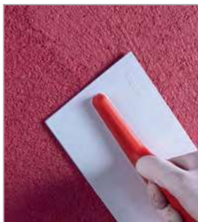
Рис. 6.16 – Заглаживание поверхности финишной декоративной штукатурки с помощью пластиковой гладилки
