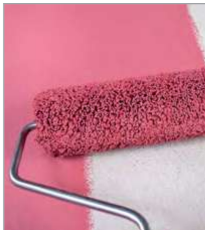
Рис. 6.14 – Нанесение цветной грунтовки
