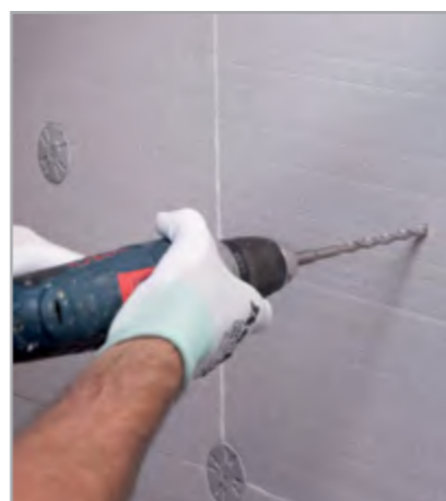
Рис. 6.9 – Сверление отверстия для вставки анкера
