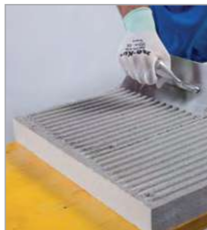
Рис. 6.5 – Клей, нанесенный равномерно на обратную сторону теплоизоляционной панели
