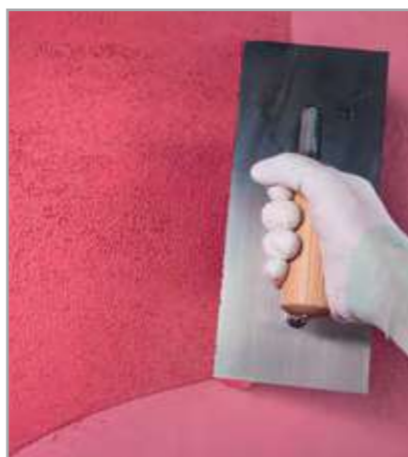
Рис. 6.15 – Нанесение декоративной штукатурки
