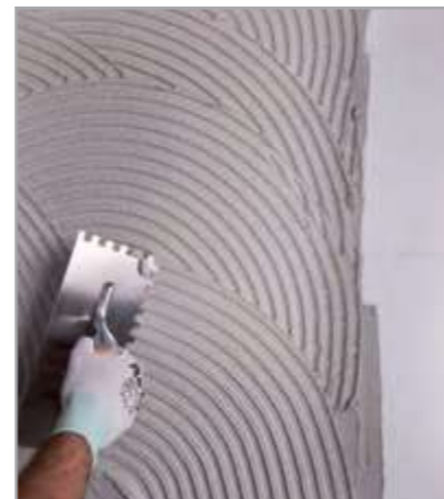
Рис. 6.11 – Нанесение первого слоя накрывочного состава
