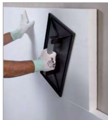
Рис. 6.8 – Придавливание панели гладилкой
