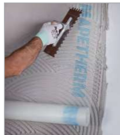
Рис. 6.12 – Укладка MAPETHERM NET
