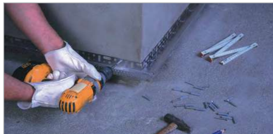
Рис. 6.4 – Закрепите поддерживающие профили с помощью дюбель-гвоздя
