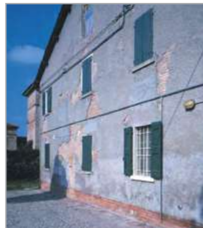
Fig. 6.2 - Отваливающиеся куски штукатурки следует удалить, перед тем как приклеивать теплоизоляционную панель
