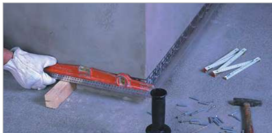
Рис. 6.3 – Размещение поддерживающих профилей: проверьте их горизонтальность, используя уровень
