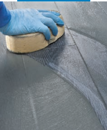
Окончательная очистка плитки с помощью целлюлозной губки
