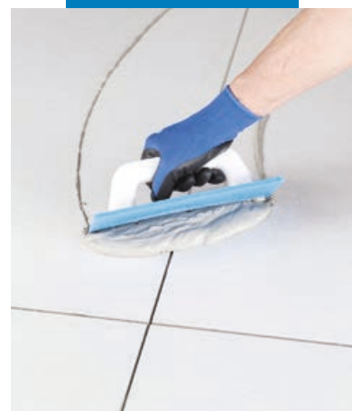
Нанесение Ultracolor Plus (Ультраколор Плюс) на пол из керамогранита резино-вым шпателем
