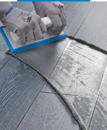
Нанесение Ultracolor Plus (Ультраколор Плюс) резиновым шпателем на пол из керамогранита с эффектом дерева
