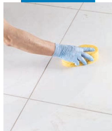
Окончательная очистка плитки с помощью целлюлозной губки
