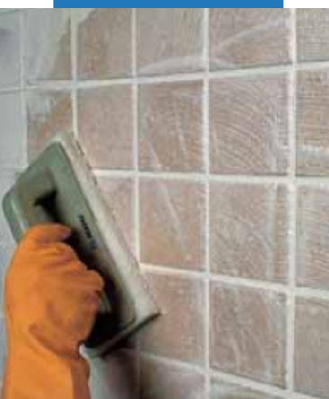
Очистка плитки одинарного обжига абразивным падом
