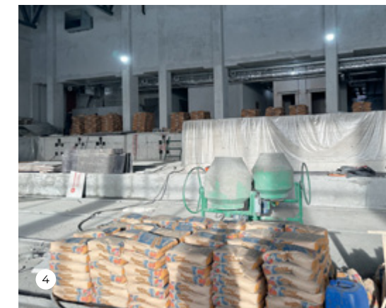
1-4. Для выравнивания чаш бассейнов применялись Nivoplan Plus (Нивоплан Плюс) и Topcem Pronto (Топчем Пронто).
