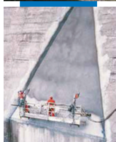
Нанесение Mapelastic на дамбу распылением
