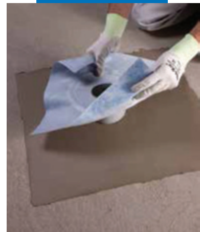
Установка вертикального дренажа на Mapelastic
