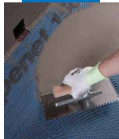
Нанесение Mapelastic на Mapenet 150 R
