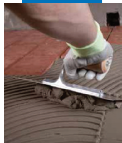
Нанесение Granirapid на гидроизоляцию Mapelastic на террасе
