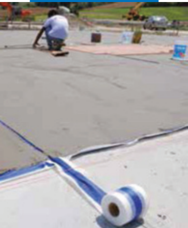
Гидроизоляция стяжки с применением Mapelastic и Mapeband
