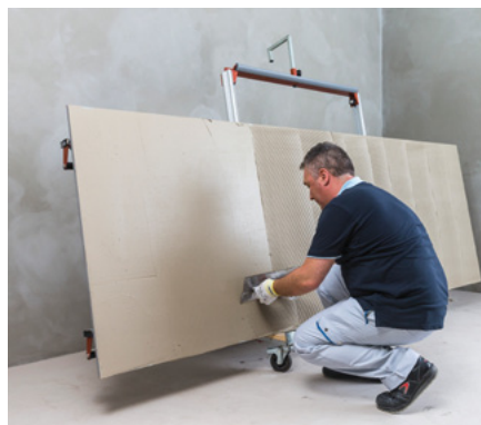
Клей наносится на основание и на плитку в одинаковом направлении
