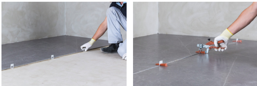
Установка разделителей в требуемое положение
