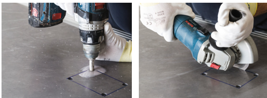
Порядок действий по созданию прямоугольного отверстия
