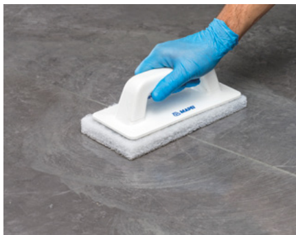
Очистка плитки с помощью пада скотч-брайт и завершение очистки с использованием губки
