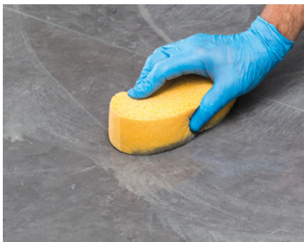
Очистка плитки с помощью пада скотч-брайт и завершение очистки с использованием губки
