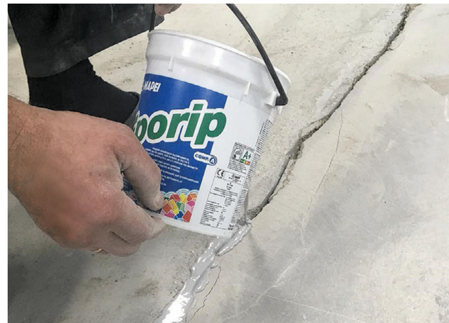
Заливка трещин в основании с помощью Eporip
