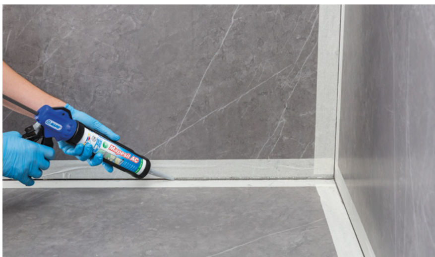
Герметизация шва по периметру с помощью Mapesil AC
