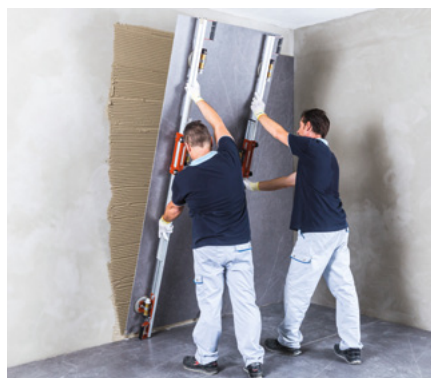
Укладка плитки на стену
