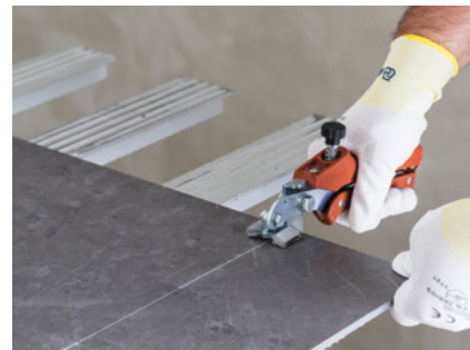
Разламывание плитки с помощью щипцов для надлома
