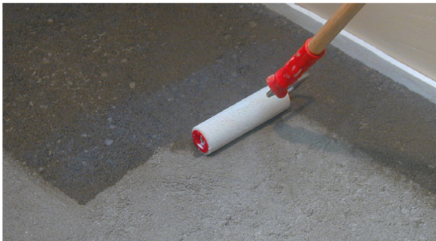
Нанесение Primer G
