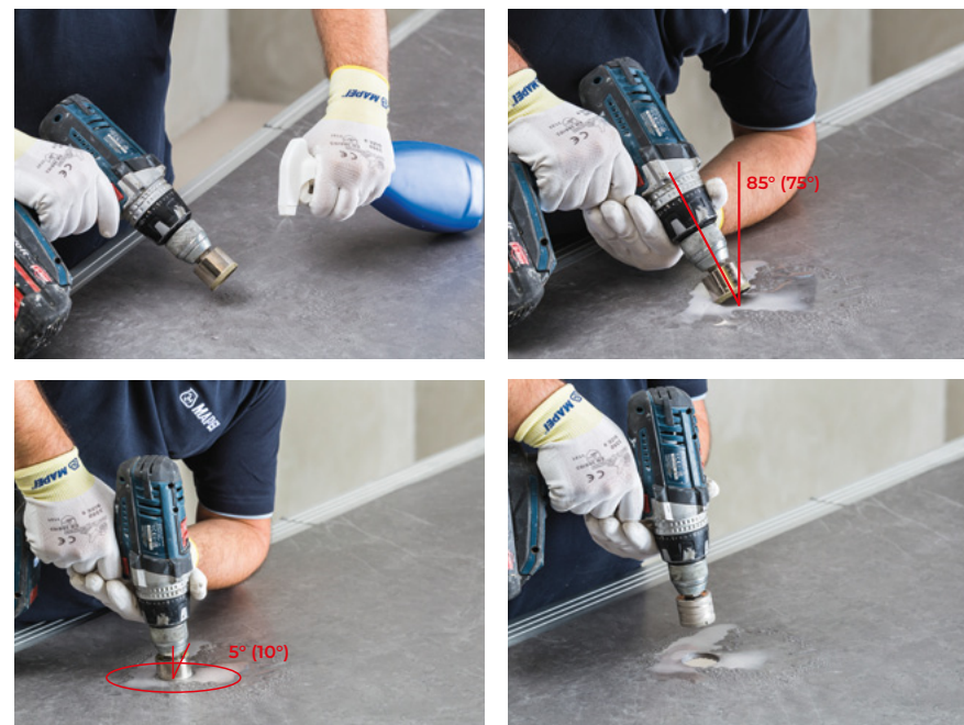
Порядок действий по созданию круглого отверстия
