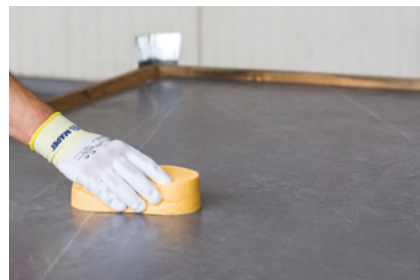
Очистка поверхности плитки
