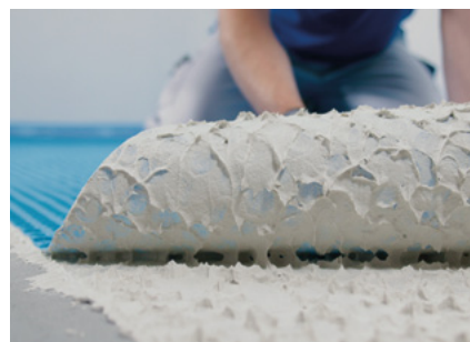
Процесс укладки Mapeguard UM 35
