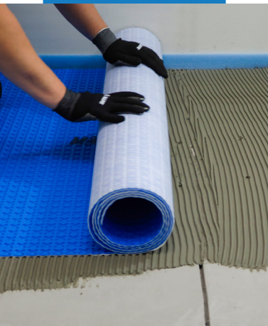
Приклеивание Mapeguard 3 (Мапегард 3)
