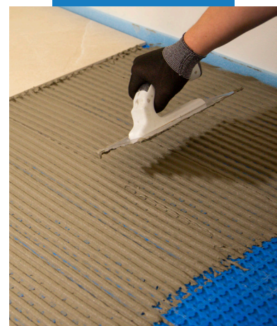
Нанесение клея на мембрану
