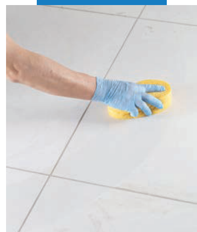
Окончательная очистка плитки с помощью целлюлозной губки
