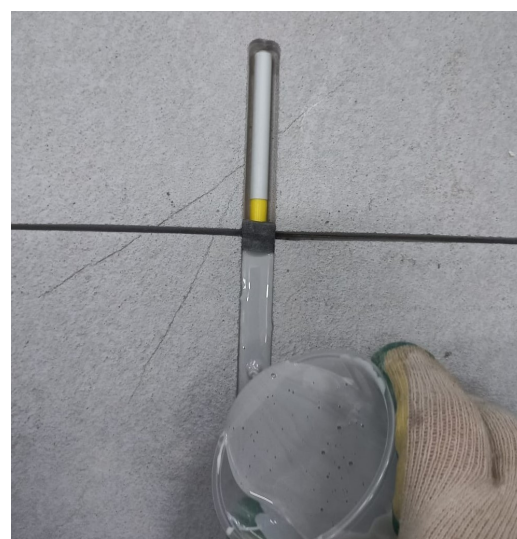
4. Заливка дюбеля смолой Эпорип (Eporip)
