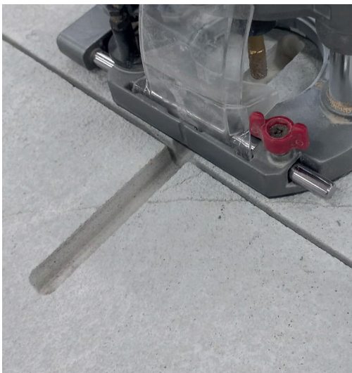
1. Создание пропила для установки Dowel for the Screed Boxes (Дюбеля для швов в стяжках) (диаметр фрезы 8,3 мм)
