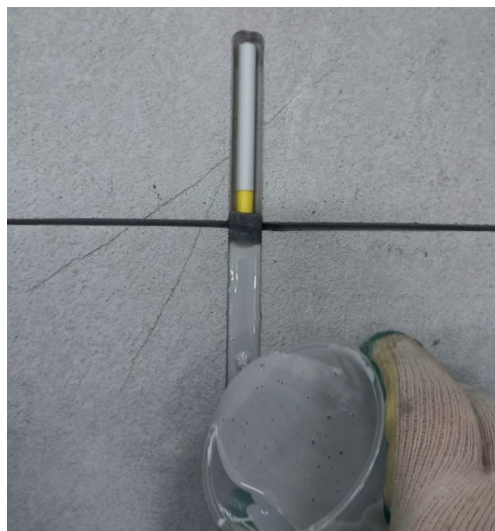
4. Заливка Dowel for the Screed Boxes (Дюбеля для швов в стяжках) смолой Eporip (Эпорип)
