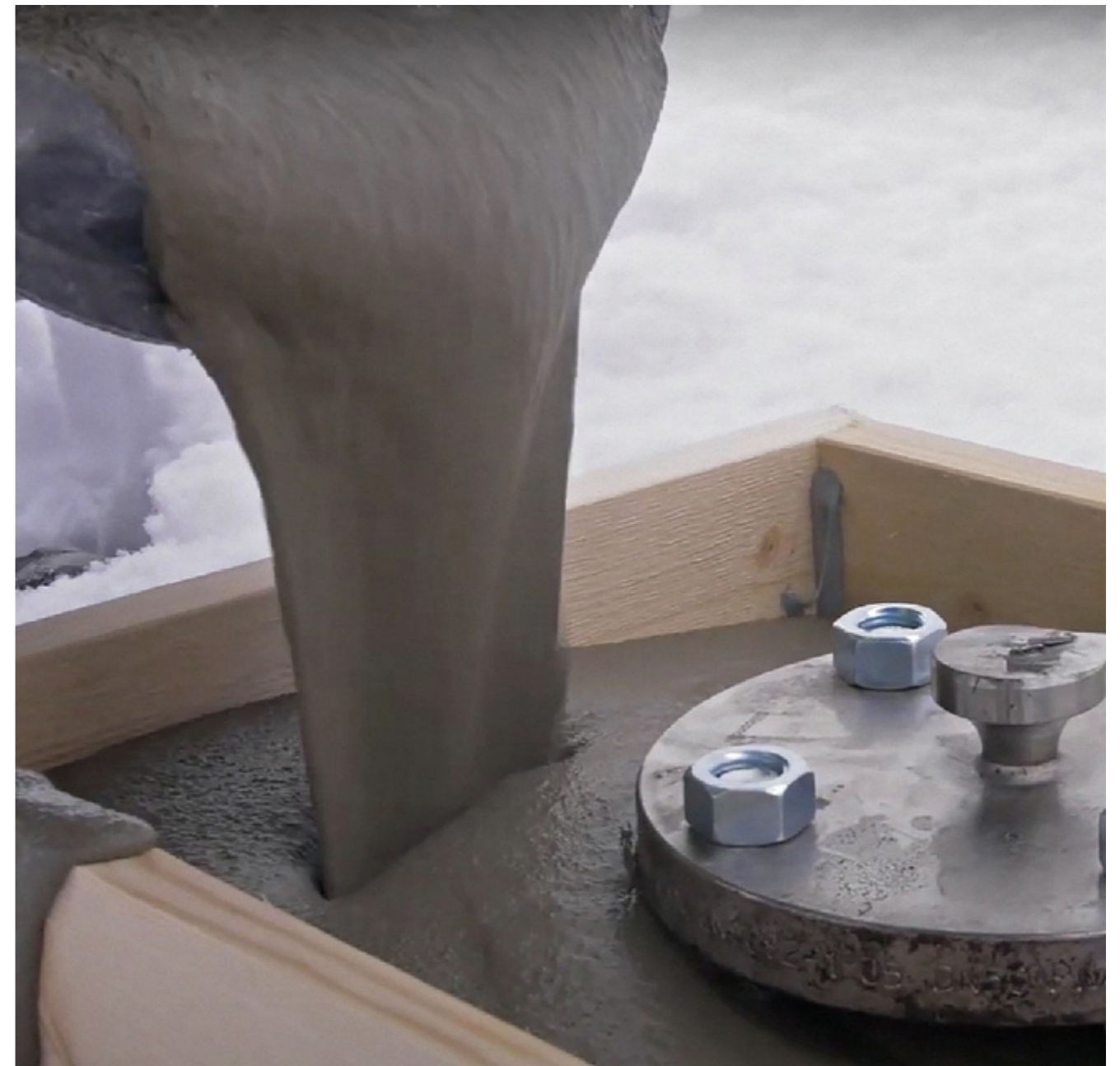
Решение 3. Монтаж металлических колонн, мачт, стоек в условиях отрицательных температур (до -10°С)
