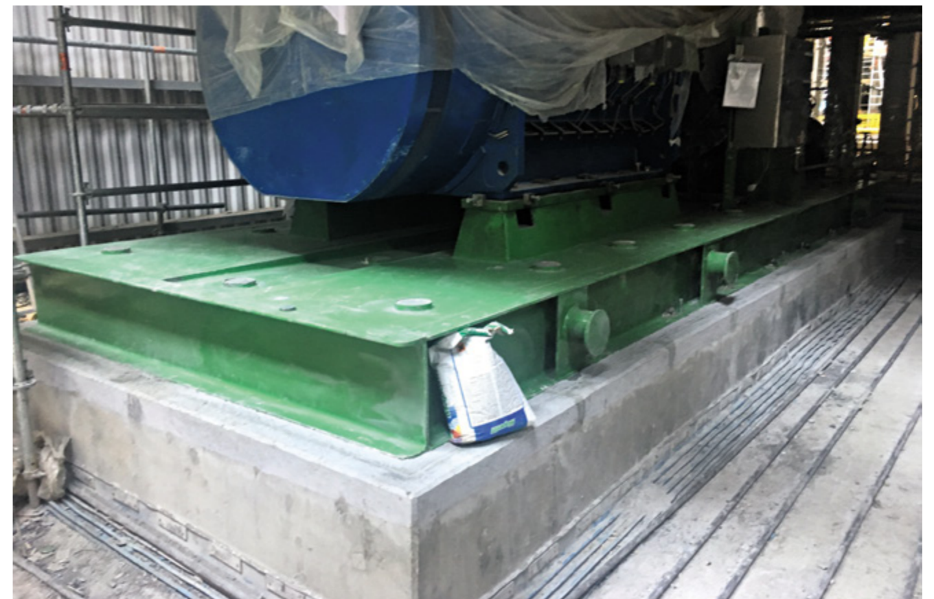
Подливка фундамента турбин, комплексов оборудования и металлоконструкций материалами МАПЕИ
