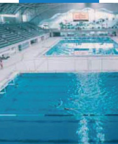
Пример укладки мозаики и клинкерной плитки в бассейне – Олимпийский центр в Сиднее (Австралия)
