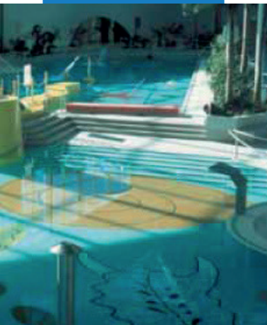
Пример укладки мозаики и клинкерной плитки в бассейне
