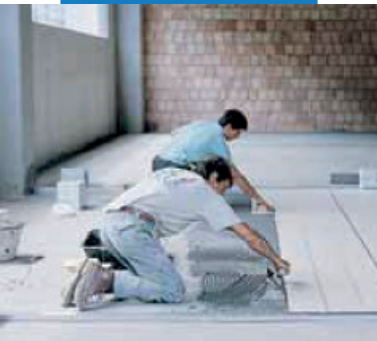
Укладка керамогранита в промышленных помещениях
