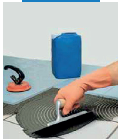
Укладка агломерата поверх имевшейся керамической плитки с использованием серого Granirapid (Гранирапид)
