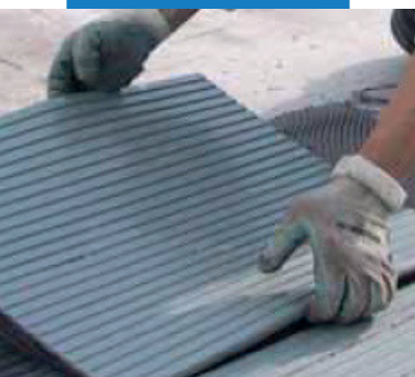
Укладка резиновой плитки с профилированной тыльной стороной с помощью клея Granirapid (Гранирапид)
