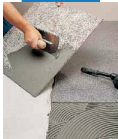
Укладка гранита с помощью серого Granirapid (Гранирапид)
