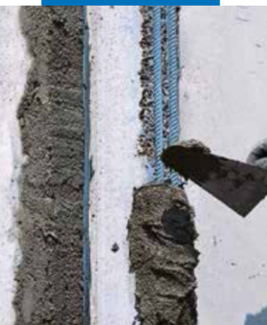
Нанесение раствора мастерком
