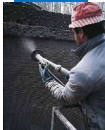
Механизированное нанесение методом мокрого торкретирования
