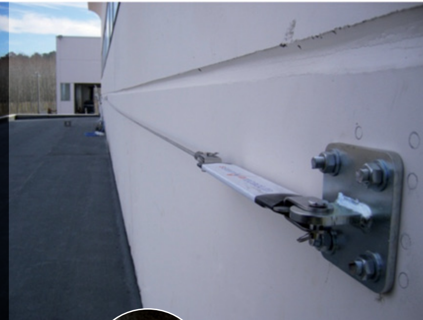
СБОКУ. Устройство защиты от падения, прикрепленное с помощью MAPEFIX VE SF.
