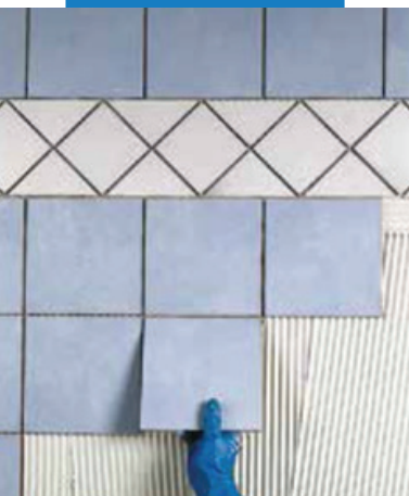
Укладка плитки ординарного обжига на оштукатуренную стену в ванной
