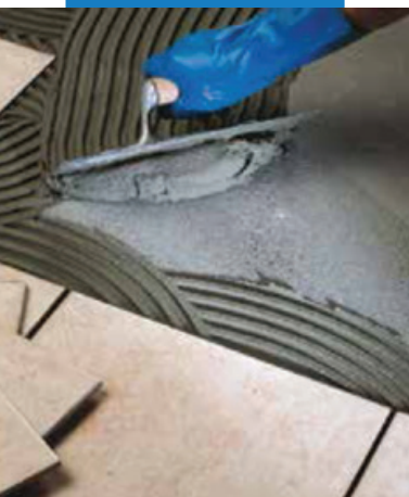
Укладка плитки ординарного обжига на пол
