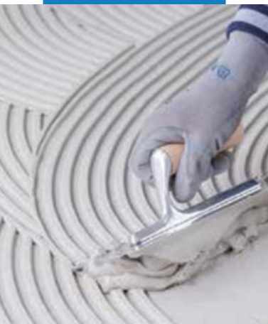
Укладка плитки ординарного обжига на стену из гипсокартона
