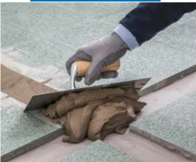
Заполнение штроб с помощью Планипатч
