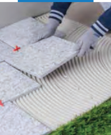
Укладка натурального камня в экстерьере
