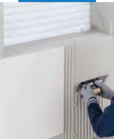
Установка крупногабаритной керамической плитки
