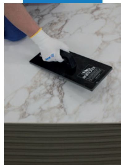
Укладка керамогранита размером 240 x 120 см
