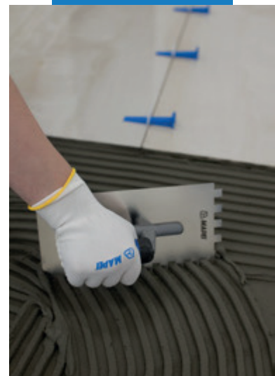
Укладка на пол керамогранита размером 160 x 80 см
