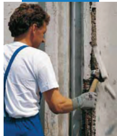
Удаление поврежденного бетона
