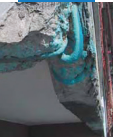
Арматура на балконе, обработанная Mapofer 1K (Мапефер 1К)
