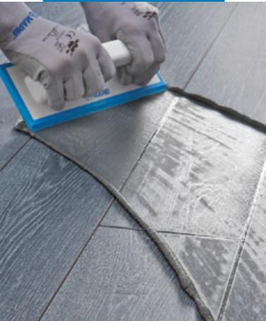
Нанесение УЛЬТРАКОЛОРА ПЛЮС резиновым шпателем на пол из керамогранита с эффектом дерева
