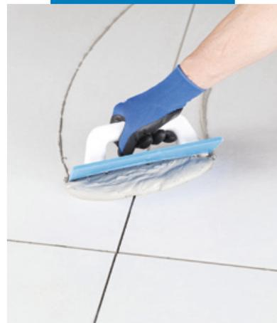
Нанесение **УЛЬТРАКОЛОР ПЛЮС** на пол из керамогранита резиновым шпателем
