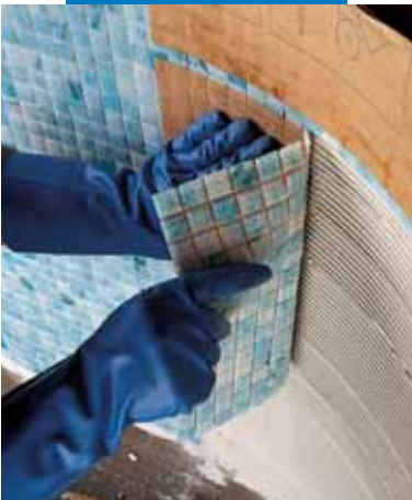
Укладка стеклянной мозаики 2x2 в бассейне с использованием Adesilex P10 и добавки Isolastic, разбавленной водой в соотношении 1:1
