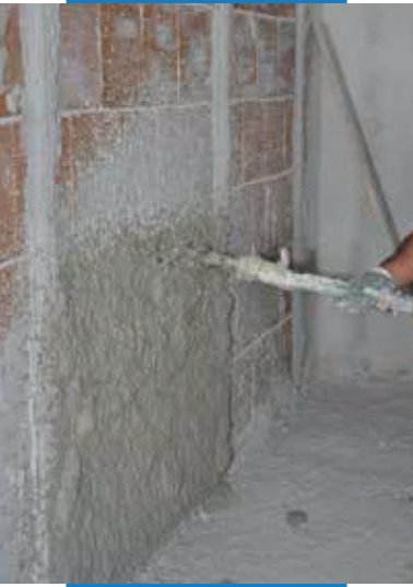
Нанесение Intomap 340 (Интомап 340) набрызгом
