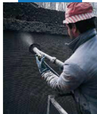
Механизированное нанесение методом мокрого торкретирования
