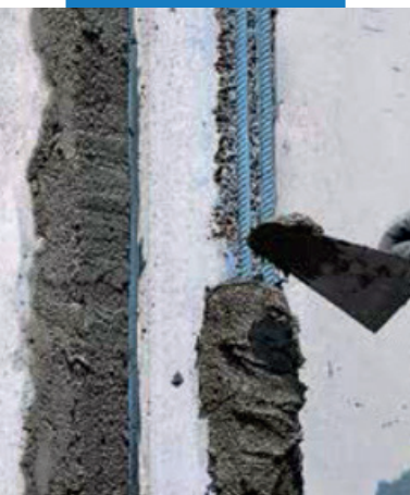
Нанесение раствора мастерком
