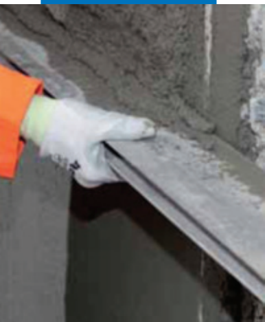
Выравнивание Марегрут 230 при помощи правила
