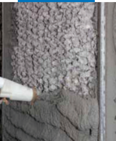
Нанесение Марегрут 230 набрызгом
