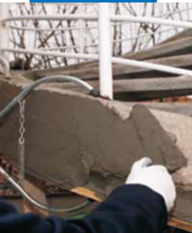
Нанесение Марегрут 230 при помощи мастерка
