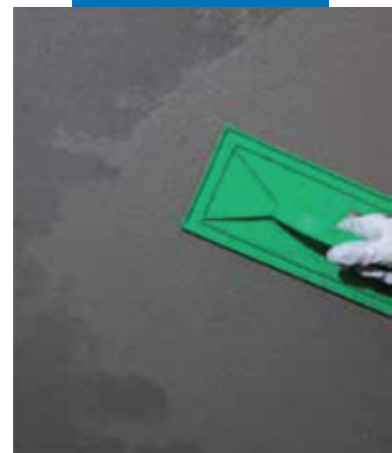
Заглаживание слоя Mapegrout 230
