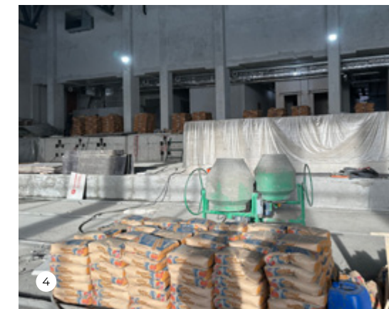
1-4. Для выравнивания чаш бассейнов применялись Nivoplan Plus (Нивоплан Плюс) и Topcem Pronto (Топчем Пронто).
