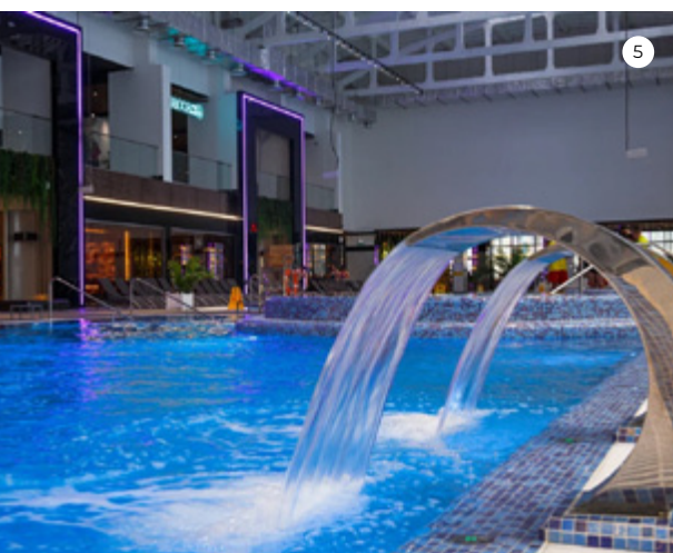
1-8. Материалы МАПЕИ применялись при устройстве бассейнов, хамама, а также для укладки плитки на улице.
