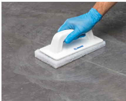
Очистка плитки с помощью пада скотч-брайт и завершение очистки с использованием губки
