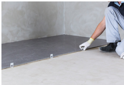
Установка разделителей в требуемое положение
