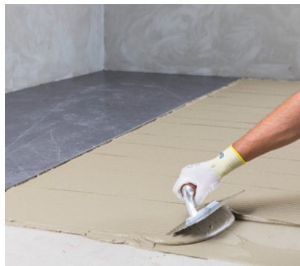
Клеевая растворная смесь наносится на основание и на плитку в одинаковом направлении
