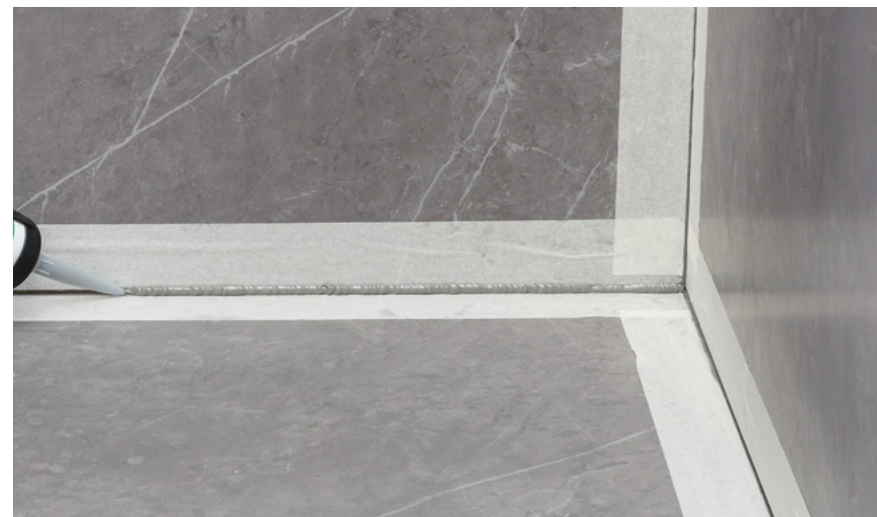
Герметизация шва по периметру с помощью XS1
