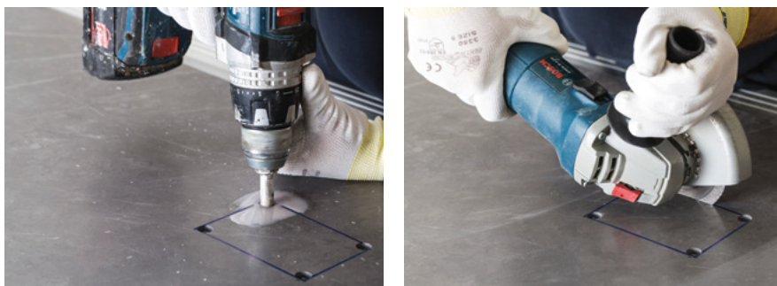
Порядок действий по созданию прямоугольного отверстия
