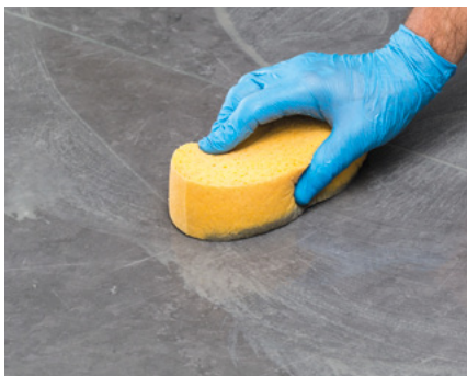
Очистка плитки с помощью пада скотч-брайт и завершение очистки с использованием губки
