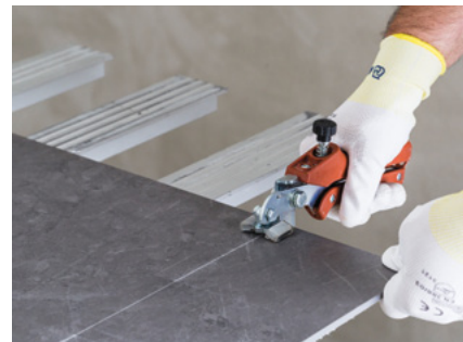
Разламывание плитки с помощью щипцов для надлома
