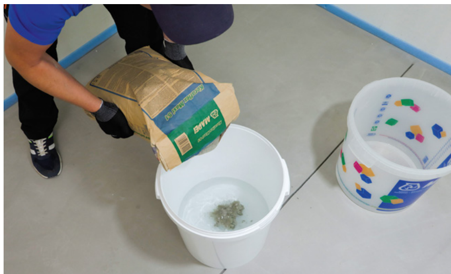
Замешивание клеевой смеси
