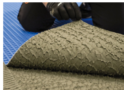
Процесс укладки Mapeguard 3
