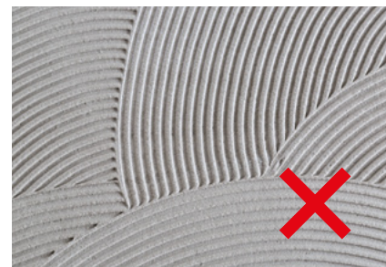
Правильное и неправильное нанесение клеевой растворной смеси
