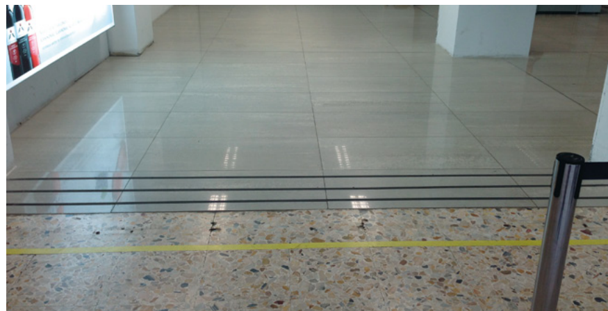
Укладка плитки поверх существующих полов
