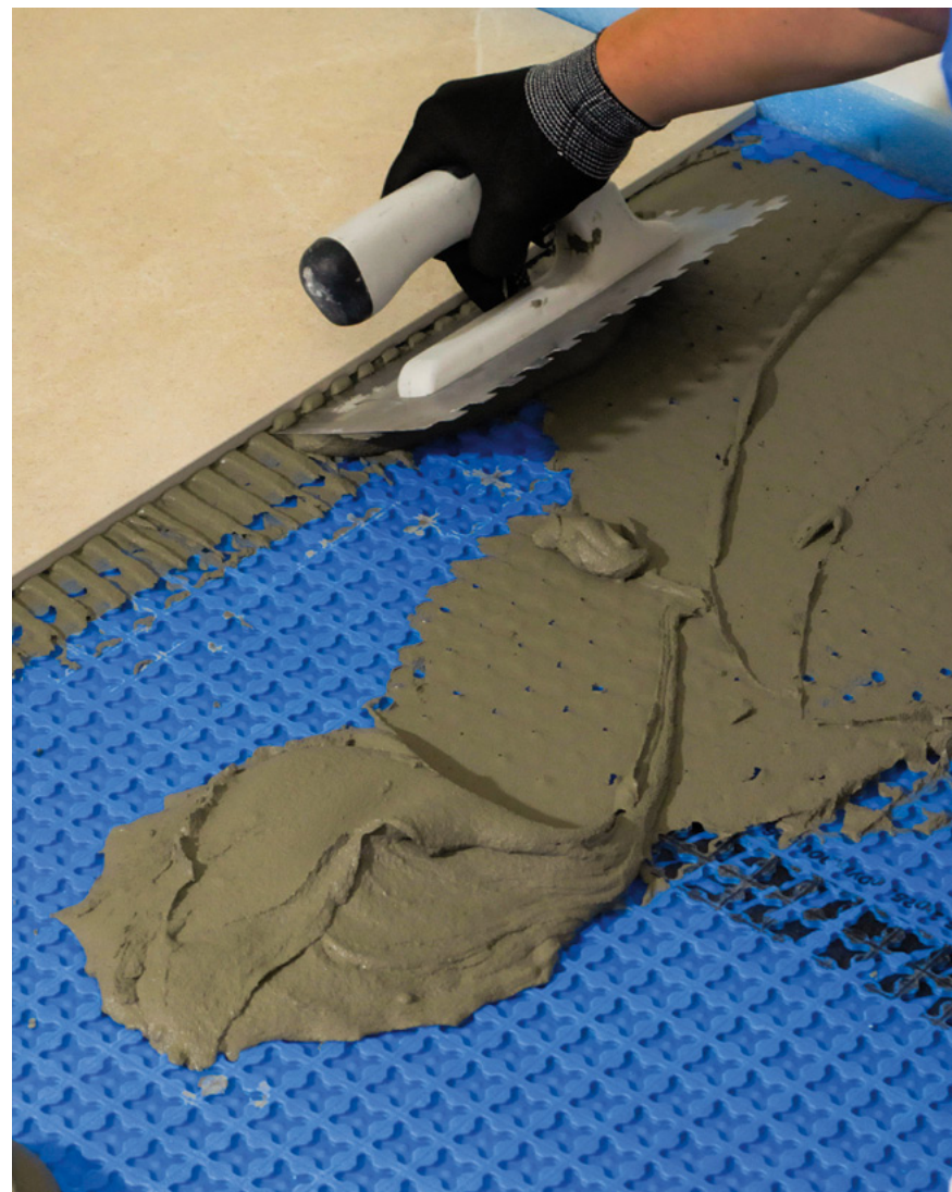
Укладка керамогранита на мембрану Mapeguard 3
