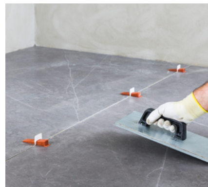
Простукивание плитки вручную или с помощью вибропанели
