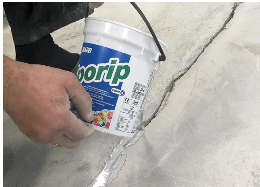
Заливка трещин в основании с помощью Eporip
