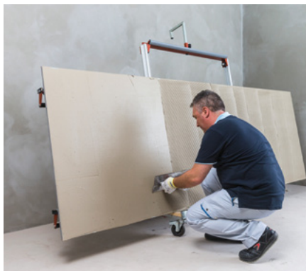
Клеевая растворная смесь наносится на основание и на плитку в одинаковом направлении
