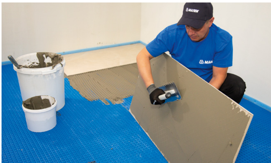
Нанесение клея на тыльную сторону плитки
