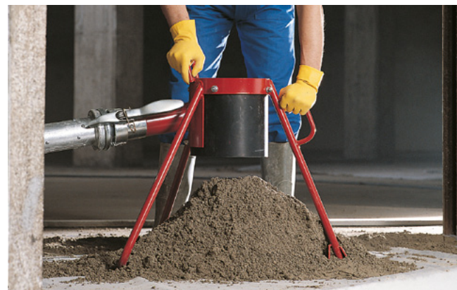
Укладка стяжки с помощью Topcem Pronto
