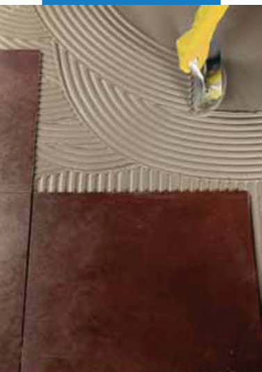
Укладка керамогранита размером 600x600 мм на пол
