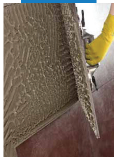
Необходимо смачивать 100% обратной стороны плитки при укладке крупноформатного гранита
