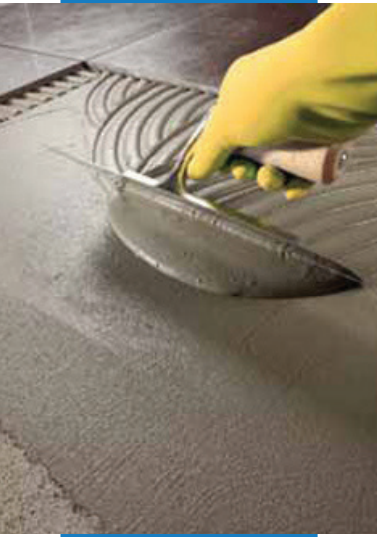
Укладка плитки на Kerabond T-R (Керабонд Т-Р) на пол
