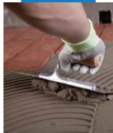
Нанесение Granirapid (Гранирапид) на гидроизоляцию Mapelastic (Мапеластик) на террасе
