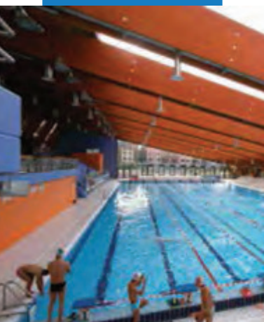
Бассейн с гидроизоляцией Mapelastic (Мапеластик): спортивный центр Скарioni - Милан - Италия
