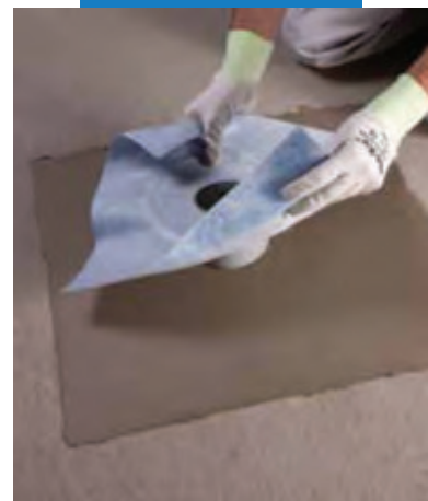
Установка вертикального дренажа на Mapelastic (Мапеластик)
