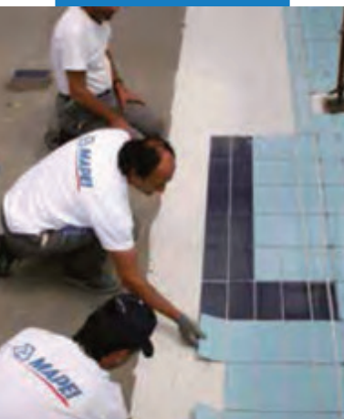
Укладка керамической плитки на Mapelastic (Мапеластик) в бассейне
