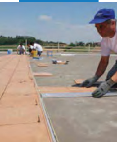
Укладка керамической плитки с применением Kerabond T-R (Керабонд Т-Р) + Admix I
