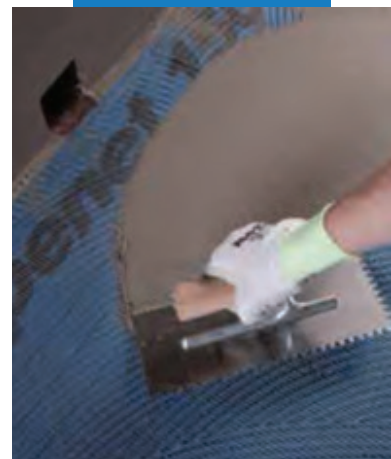
Нанесение Mapelastic (Мапеластик) на Mapenet 150 R (Мапенет 150 Р)
