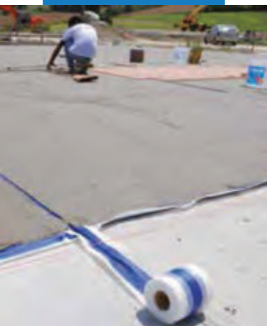
Гидроизоляция стяжки с применением Mapelastic (Мапеластик) и Mapeband (Малебанд)
