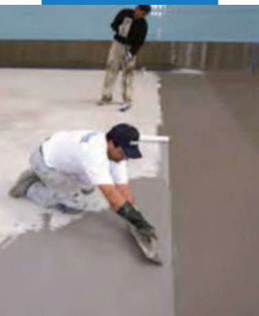
Гидроизоляция бассейна с применением Mapelastic (Мапеластик)
