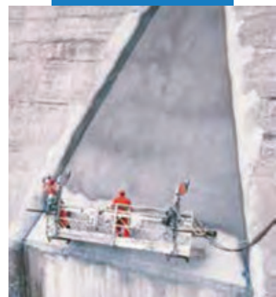
Нанесение Mapelastіc (Мапеластік) на дамбу распылением
