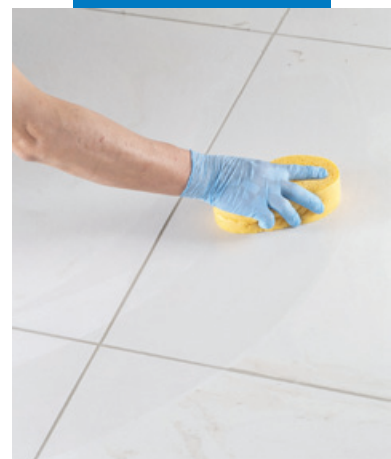
Окончательная очистка плитки с помощью целлюлозной губки
