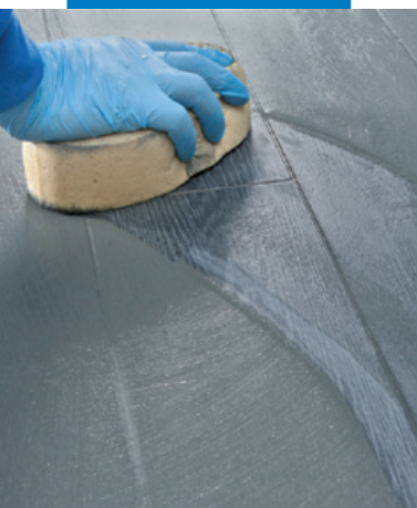
Окончательная очистка плитки с помощью целлюлозной губки
