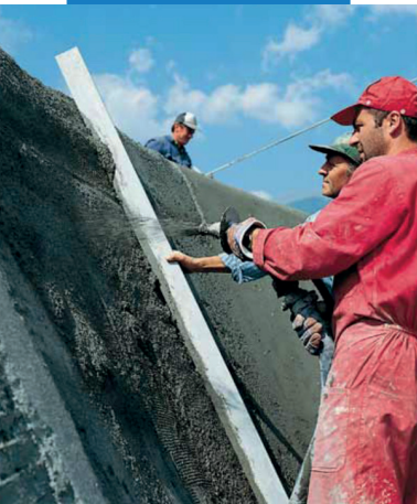
Механизированное нанесение Mapegrout T40 (Мапеграут Т40)
