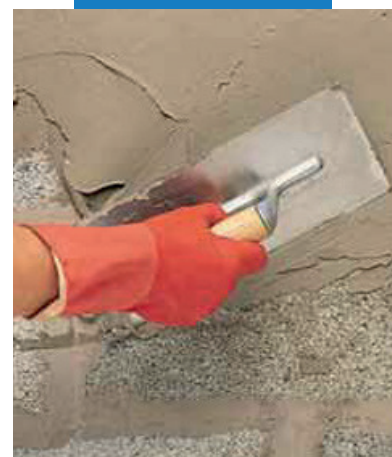
Нанесение Planiseal 88 (Планисил 88) кельмой
