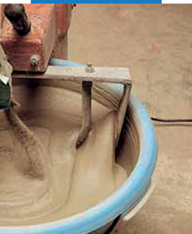
Смешивание Planiseal 88 (Планисил 88) с водой
