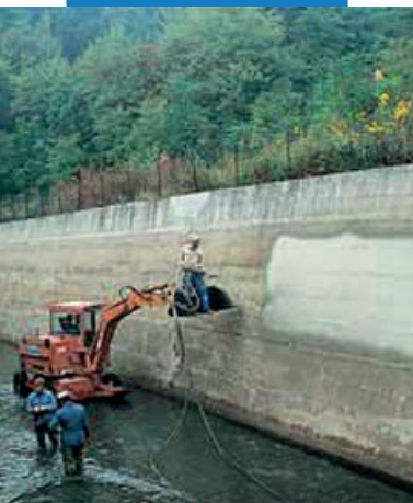
Нанесение Planiseal 88 (Планисил 88) напылением на подводящий канал гидроэлектростанции
