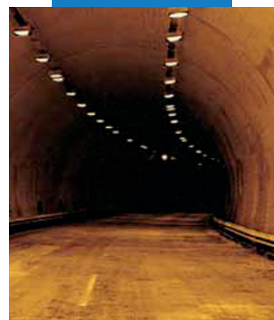
Нанесение Planiseal 88 (Планисил 88) напылением в автодорожной галерее
