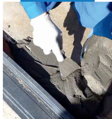
Заполнение штроб Планипатч с песком с толщиной нанесения более 2,5 см
