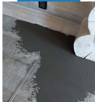
Выравнивание перепадов с выведением «в ноль»
