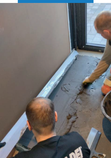
Ремонт и выравнивание входной зоны
