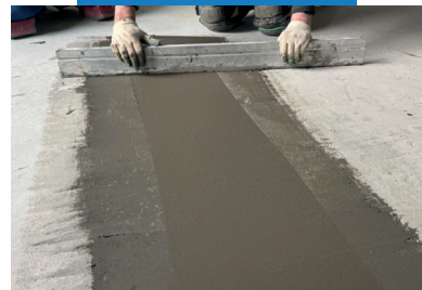
Проведение локального ремонта стяжки
