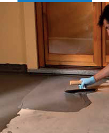
Нанесение гидроизоляции на террасе с помощью шпателя
