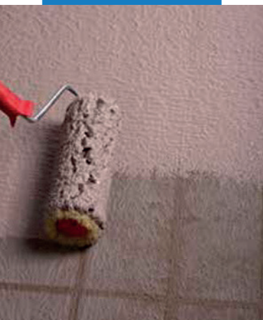
Нанесение гидроизоляции с помощью валика
