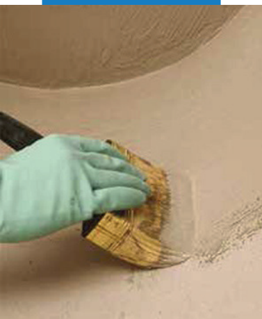
Нанесение гидроизоляции с помощью кисти
