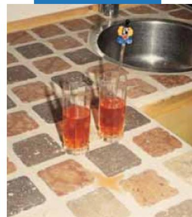
Пример приклеивания и заполнения швов на кухонной столешнице
