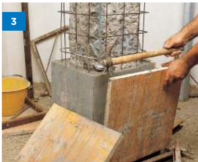
Решение 3. Ремонт вертикальных несущих конструкций методом заливки ремонтных составов в опалубку.
