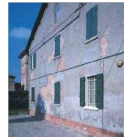
Рис. 6.2 - Отваливающиеся куски штукатурки следует удалить, перед тем как приклеивать теплоизоляционную панель
