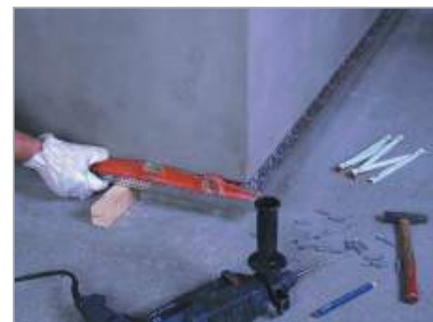
Рис. 6.3 – Размещение поддерживающих профилей: проверьте их горизонтальность, используя уровень
