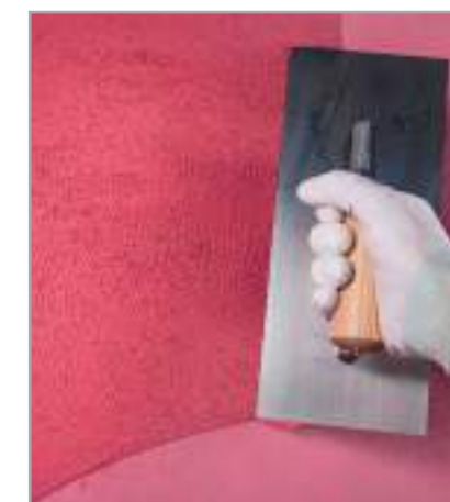
Рис. 6.15 – Нанесение декоративной штукатурки
