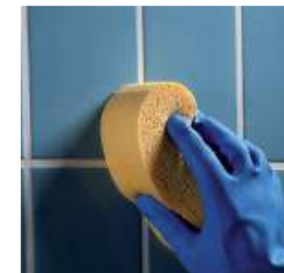
Рисунок 5.8 – Финишная очистка с помощью чистой губки
