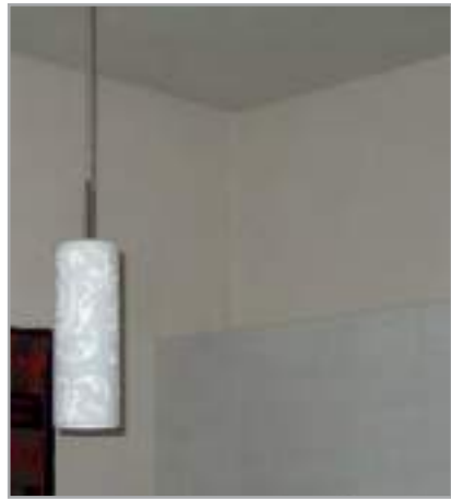
Комната в здании без наружной теплоизоляции
