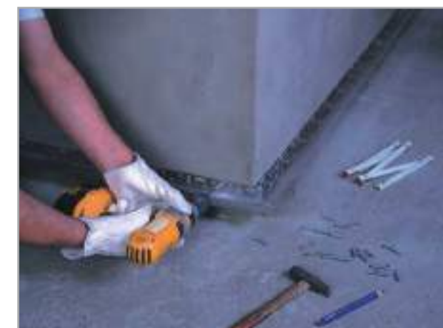
Рис. 6.4 – Закрепите поддерживающие профили с помощью дюбель-гвоздя
