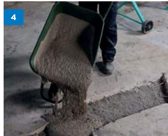
Решение 4. Ремонт горизонтальных конструкций составами наливного типа.
