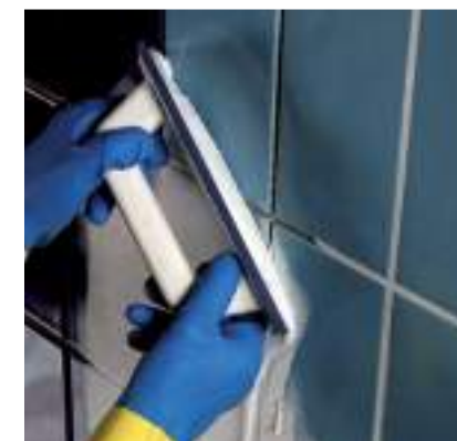
Рисунок 5.6 – Затирка облицовочного материала KERAPOXY CQ
