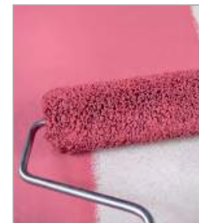
Рис. 6.14 – Нанесение цветной грунтовки
