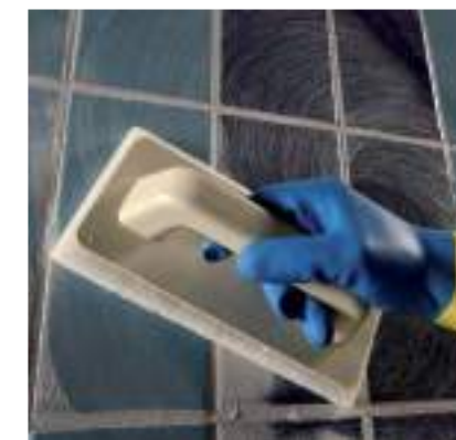
Рисунок 5.7 – Очистка поверхности плитки с помощью щетки SCOTCH-BRITE®
