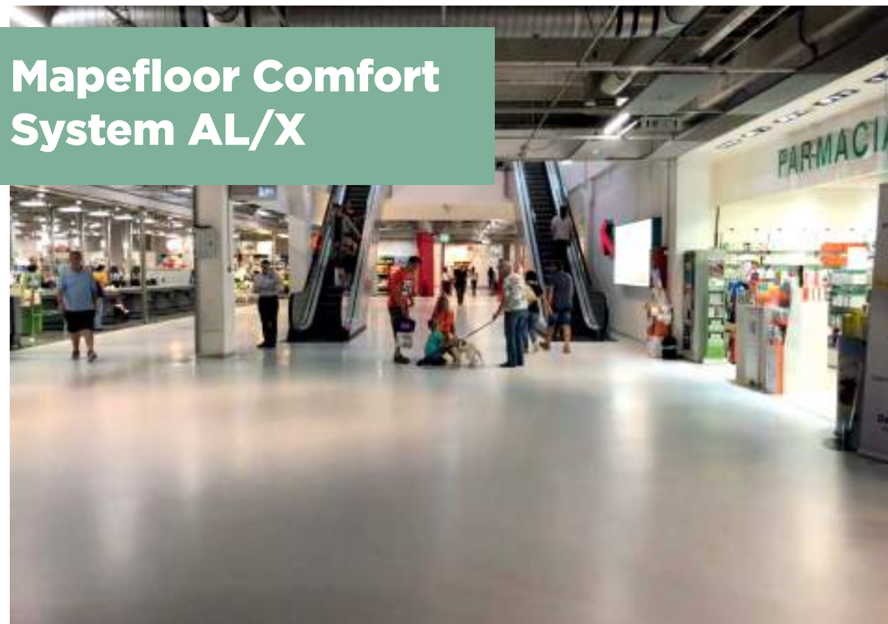
Полиуретановое алифатическое эластичное гибкое гладкое покрытие для полов в зданиях гражданского назначения. Толщина 6 мм.
