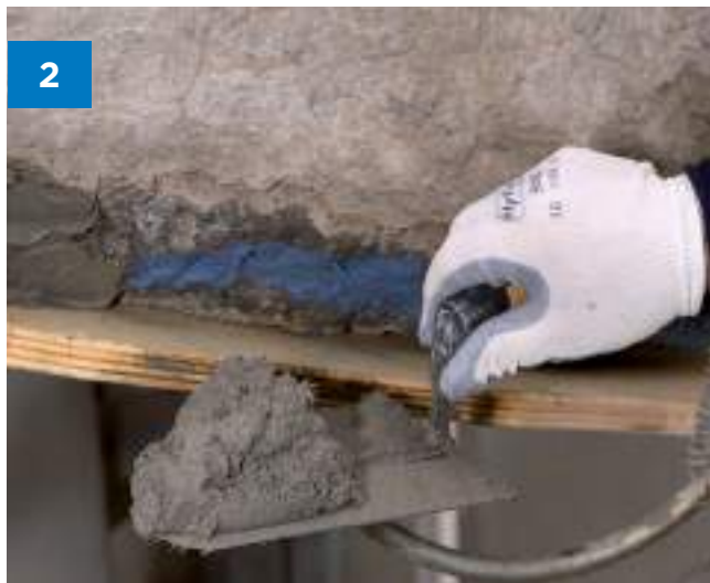
Решение 2. Ремонт потолочных бетонных конструкций составами тиксотропного типа.
