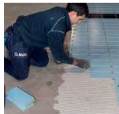
Рисунок 5.3 – Укладка облицовочного материала на дно бассейна
