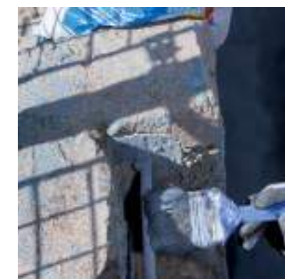
Рисунок 4.1 – Нанесение MAPEFER 1K на арматурные стержни
