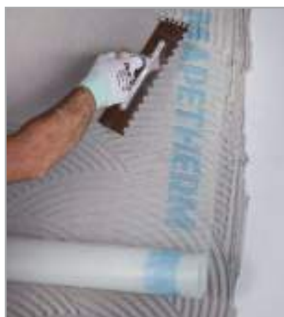
Рис. 6.12 – Укладка MAPETHERM NET
