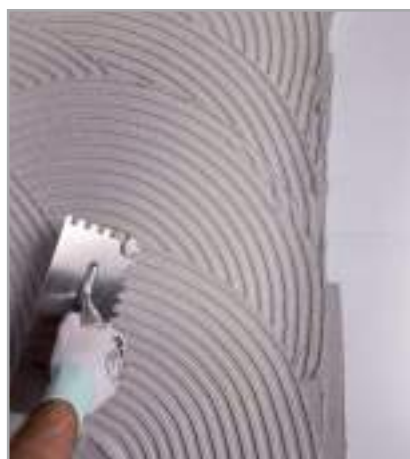
Рис. 6.11 – Нанесение первого слоя накрывочного состава
