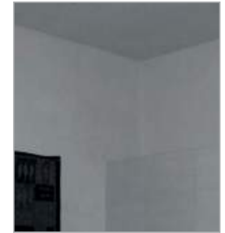
Комната в здании, теплоизолированном с помощью Mapetherm System
